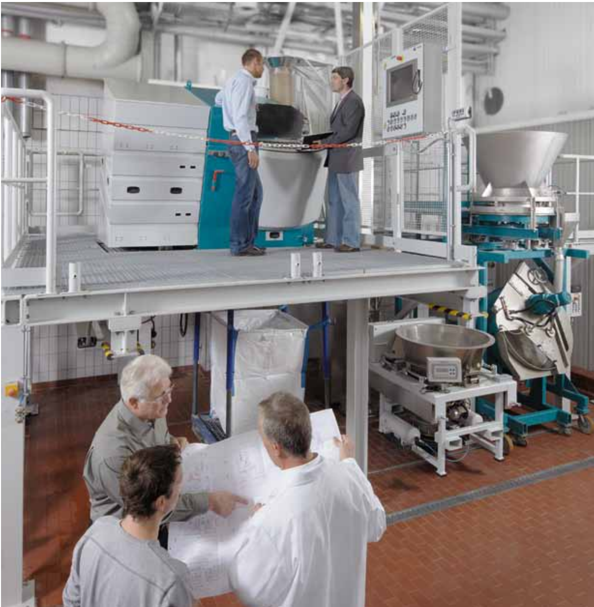
Centre de recherche technique à Hardheim, vue partielle de la technique de mélange
